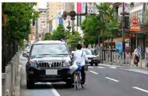
路肩カラー化での整備
