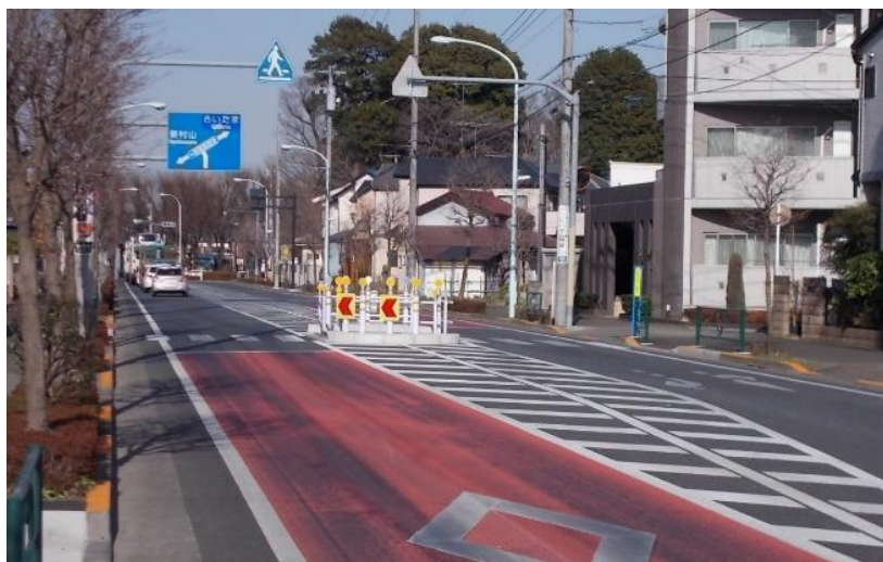
東京都清瀬市での 二段階横断施設導入後の様子
